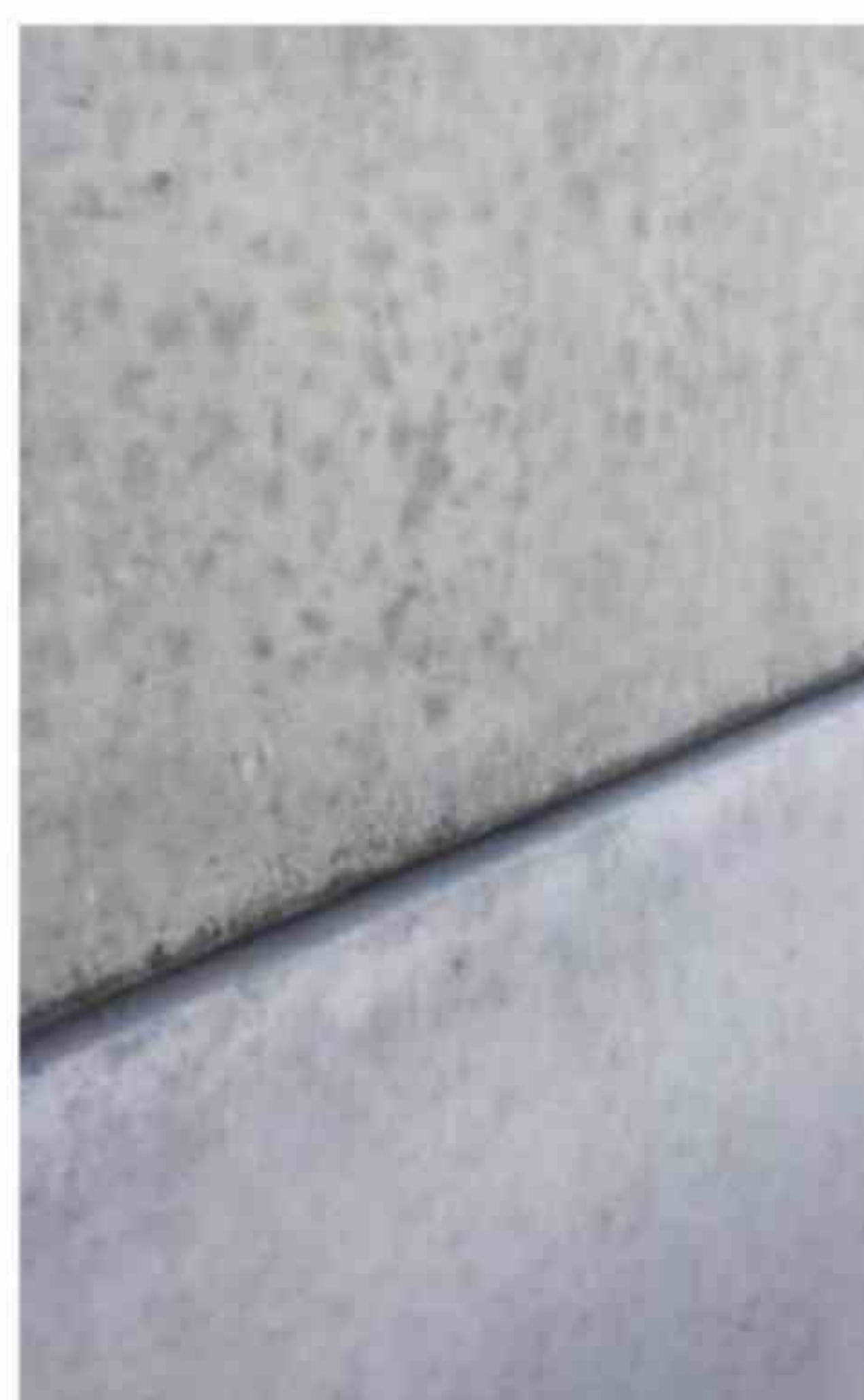
宽窄不一处理完成
