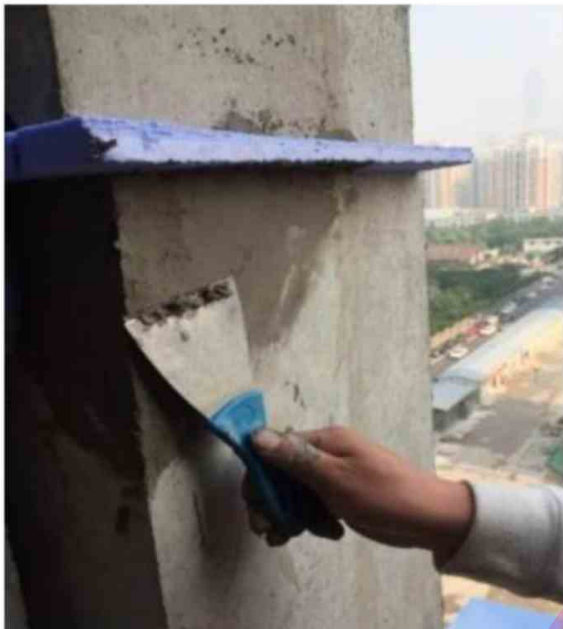
崩边掉角处修补
