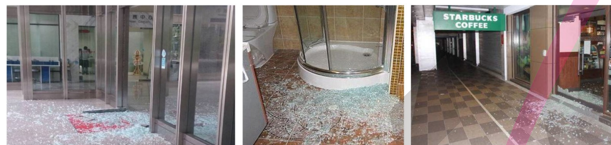
常见的玻璃破坏现象
