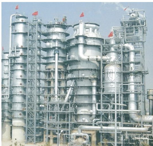
高温化工设备管道的防腐
