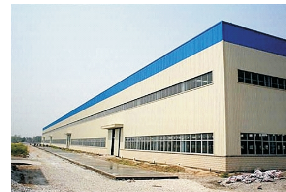
钢结构厂房的防腐
