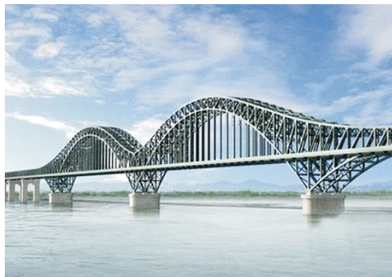
跨海大桥钢结构防腐
