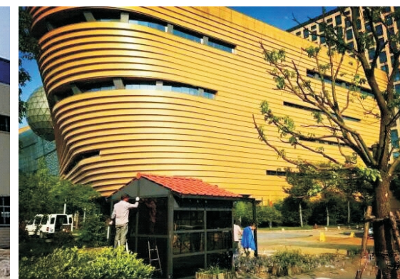
钢铁艺术品及钢结构防腐
