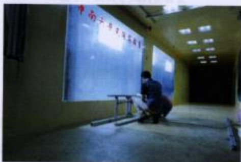
图 1 绝缘电缆安装照片
