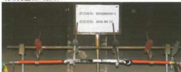
线路完整性试验后:
