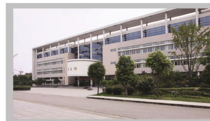
徐州医学院新校区图书馆消防工程
