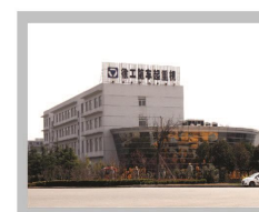
徐州徐工随车起重机有限公司消防工程
