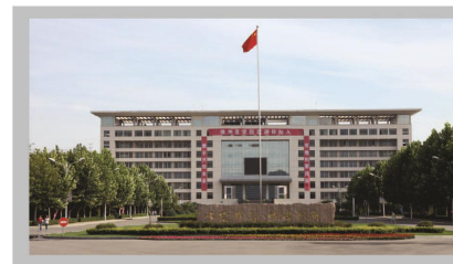
徐州医学院新校区主楼消防工程
