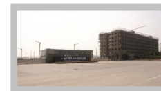
徐工集团挖掘机事业部消防工程
