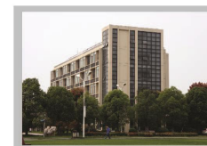
徐州医学院新校区动物实验中心消防工程
